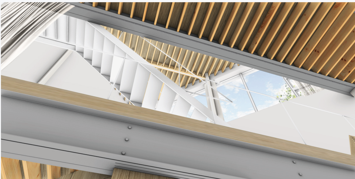
見上げ：JBF の間を縫って視線が斜め上方へ抜ける 軽量溝形鋼がスラブの小口として即物的に室内に現れる
